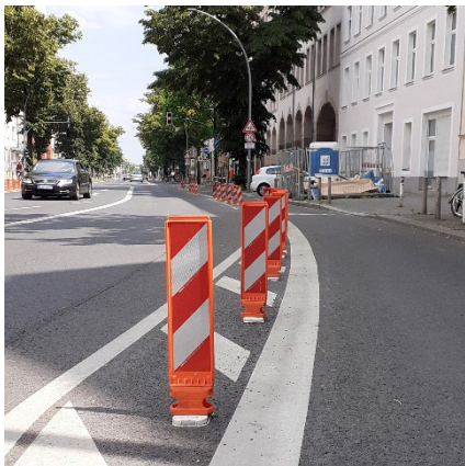
Protected Bike Lane bestehend aus fest verschraubten, weißen Leitfüßen und reflektierenden Leitboys
