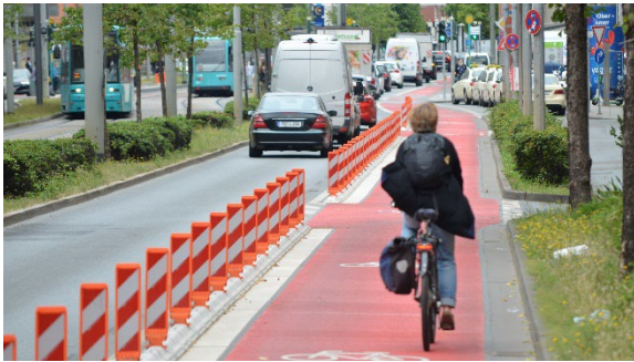
Die Protected Bike Lane von horizont (hier: die weiße Leitschwelle deutet auf ein dauerhaftes Radwegsystem hin. Wäre sie gelb, würde es sich um einen temporär eingerichteten Radweg handeln)
